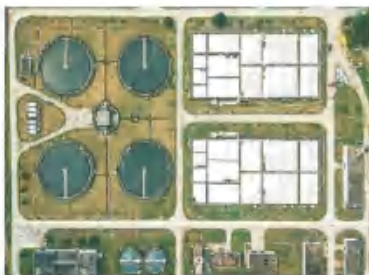
Очистка сточных вод в промышленности
